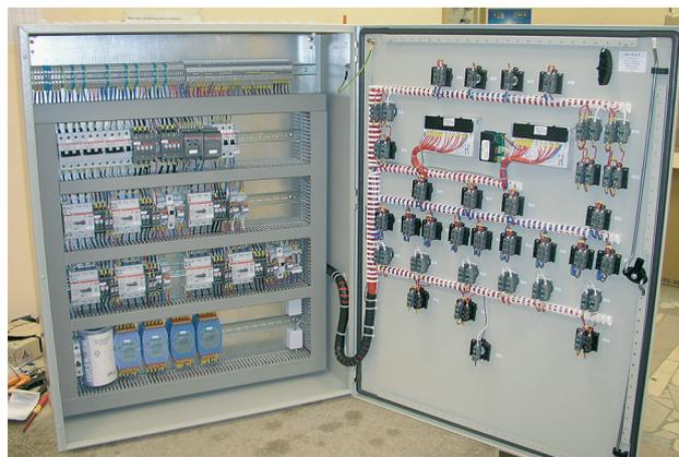
*Рис. 57. Шкаф управления тепловым пунктом*
