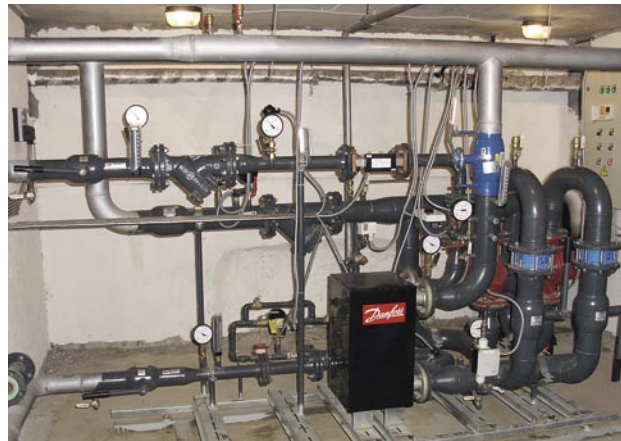
Рис. 1. Типовое жилое здание в районе Жулебино (г. Москва) и установленный в нем БТП фирмы Danfoss.
